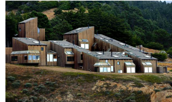
The Sea Ranch, California. Voorbeeld van rustig en passend materiaalgebruik binnen bosrijke omgeving.
